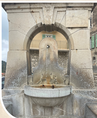
Remise en eau de la fontaine avec adduction d'eau de la source du Piol
